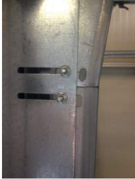
Foto 2: Het vastboren van de hoeklijnen aan de muur
