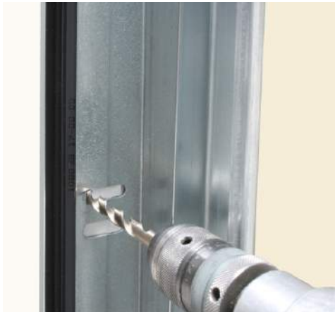
Foto 2: Het vastboren van de hoeklijnen aan de muur
