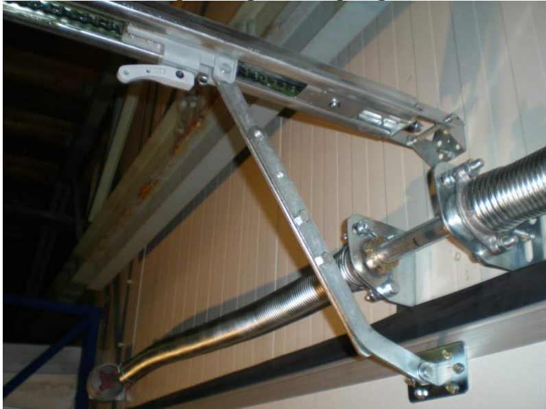
Foto 19: Verbinding kettingrail met garagedeur
