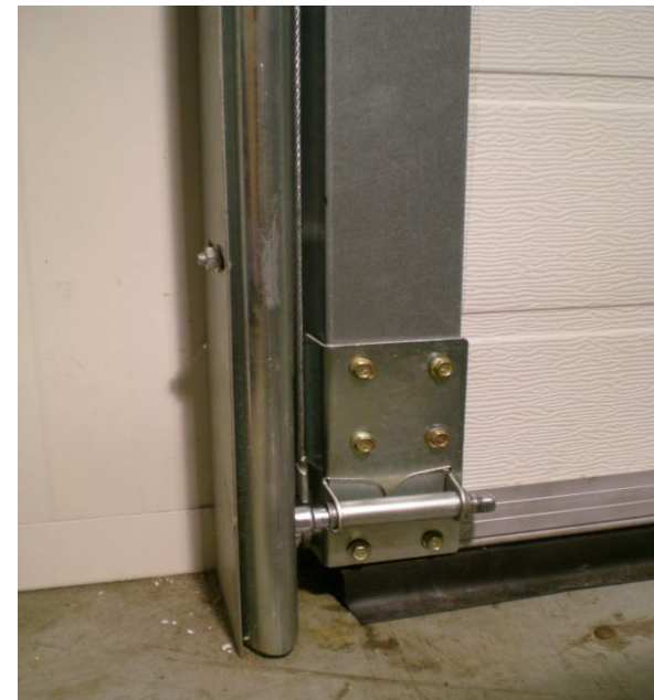
Foto 1: Onderste linker loopwielhouder
